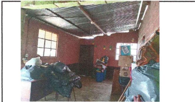
**FOTOGRAFIA 2. SE PROPONE CAMBIAR TECHO POR LAMINA TROQUELADA Y COLOCACION DE ESTRUCTURA METALICA**
